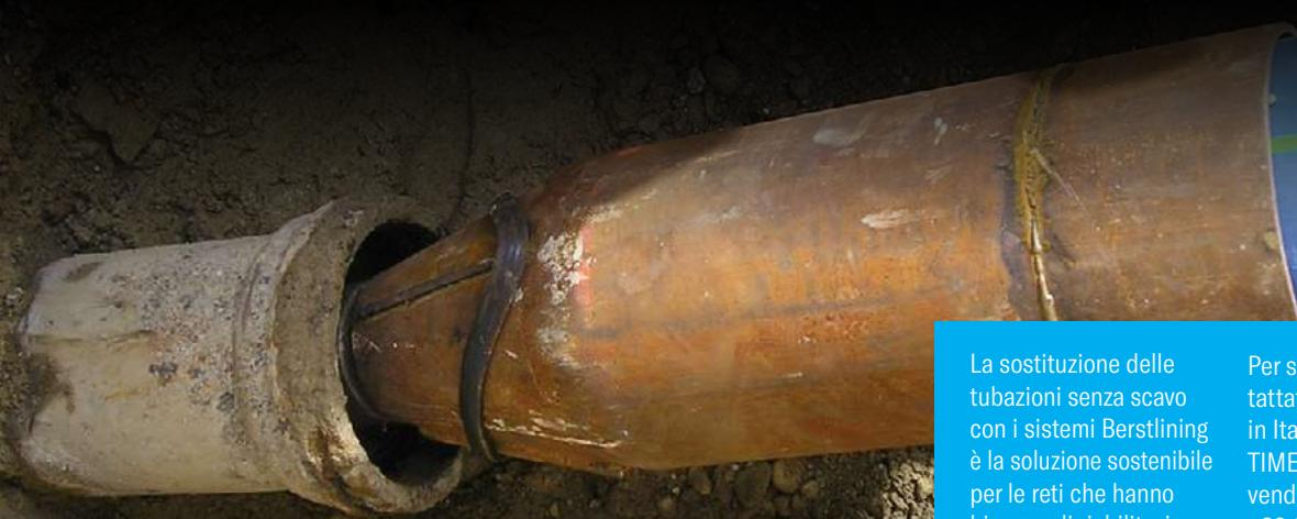
La sostituzione delle tubazioni senza scavo con i sistemi Berstlining è la soluzione sostenibile per le reti che hanno bisogno di riabilitazione.
