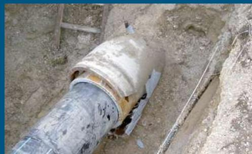
tubazione da inserire. Attraverso il tiro delle aste - con attrezzatura speciale di tiro a funzionamento idraulico e con azione continua senza percussione - la testa taglia o allarga la condotta esistente e, allo stesso tempo, traina e posa la nuova condotta. Il berstlining statico è utilizzato per la sostituzione di tubazioni in acciaio, ghisa sferoidale, cemento armato e PRFV, ma anche in tutti gli altri materiali qualora non si usi la testa tagliente.
